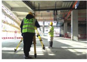
人工配合机器人现场放线
