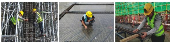
直螺纹套筒力矩现场检测
