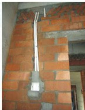
图1 传统做法墙体破坏严重
