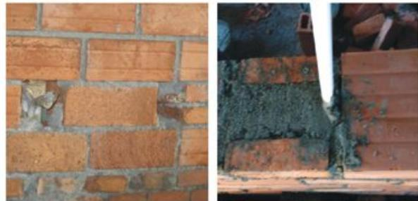
图3 水电管线同步砌筑
