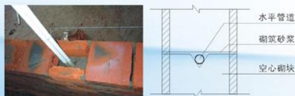
100-120砖墙包管砌筑方法 图6 100-120砖墙包管砌筑方法
