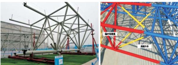
图16钢桁架单元焊接
