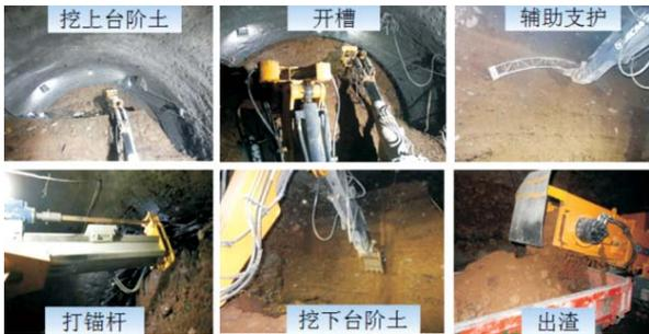
图5.3 台车施工步序图
