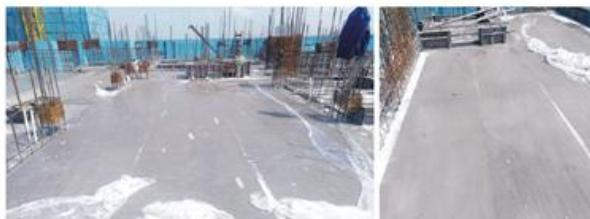
收完第一道面后，可直接采用薄膜进行覆盖，初凝后洒水养护。经实践，采用本方法收面、养护可有效控制混凝土表面裂缝，减少渗漏风险，操作方便，可控性强。
