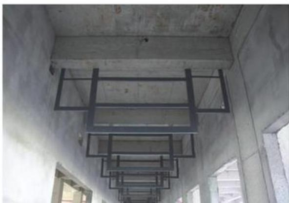
图片5-4-1-2 综合支吊架现场安装
