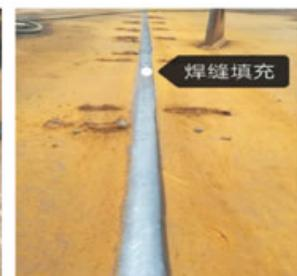
焊缝饱满、无夹渣、无气孔
