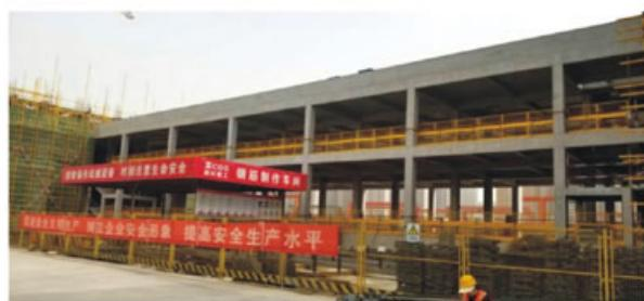
值得一提的是，每一个预制构件都有独一无二的“身份编码”。构件脱模后被贴上二维码，转运到施工堆场，按照出厂自带的编码信息进行安装。通过二维
