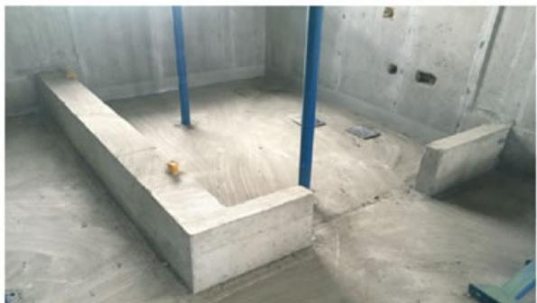
二次结构混凝土反坎随主体结构一次成型
