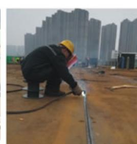
所有焊接材料、方法、工艺参数等均通过焊接工艺评定确定，施工现场优先采用自动焊，对自动焊难以实施的焊缝，采用手工电弧焊。
