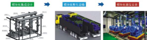
图1-2 模块化装配施工模式实施图
