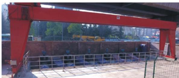
图34 10 $\text{m}^3/\text{s}$ 导流泵站
